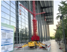
MT2D06轻型可移动智能组塔装置
